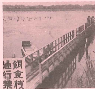
完成した白鳥のえ付棧橋
