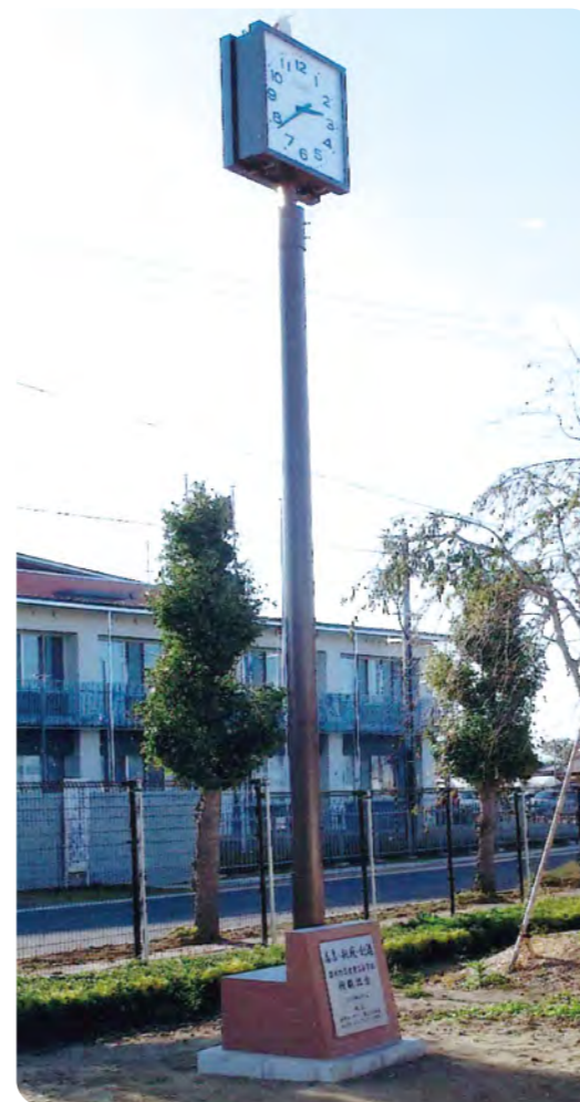
立派に完成したソーラー式ボール電波時計塔 (全高5.38m、時計面は75cm四方)
