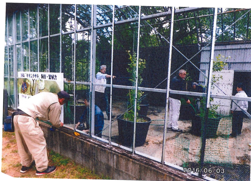
「エノキ 10 鉢」飼育・繁殖舎：看板取付作業中！
